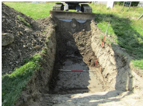
Figur 6: Schakt 18 med moderna fyllmassor. Foto mot ostnordost av Susanne Pettersson.
