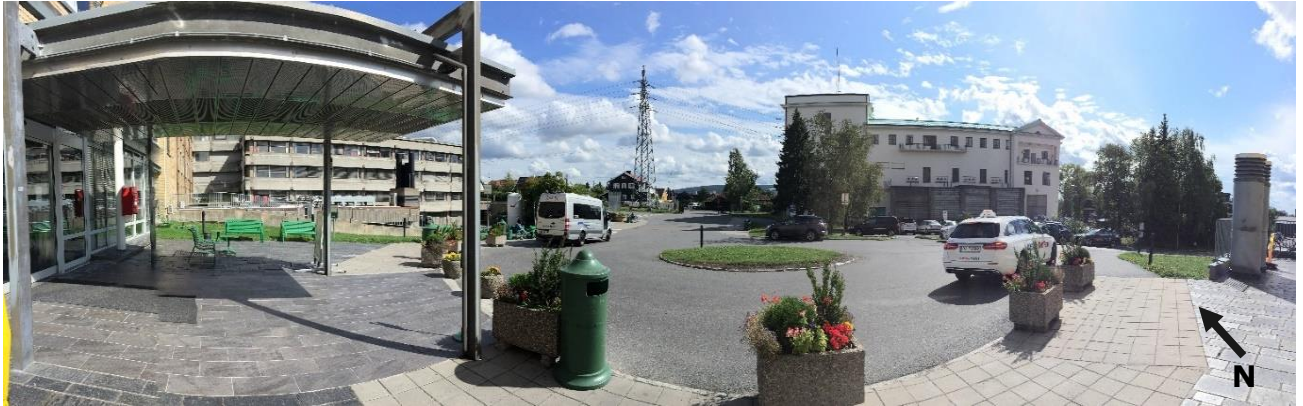
Figur 13. Eksisterende hovedinngang sett fra sør
