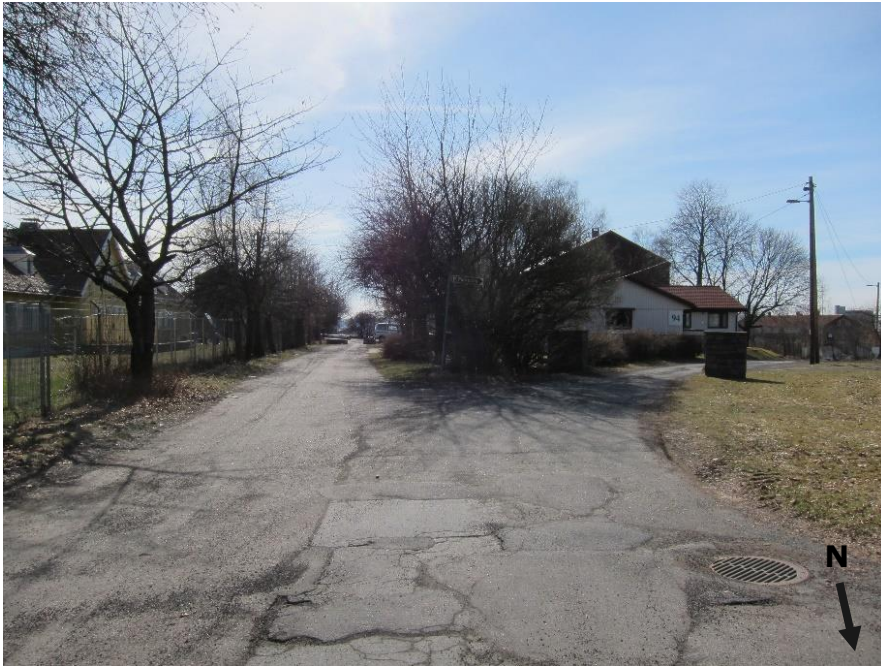
Figur 10. Det interne gatenettet ved Sinsenveien 76 (til høyre)
