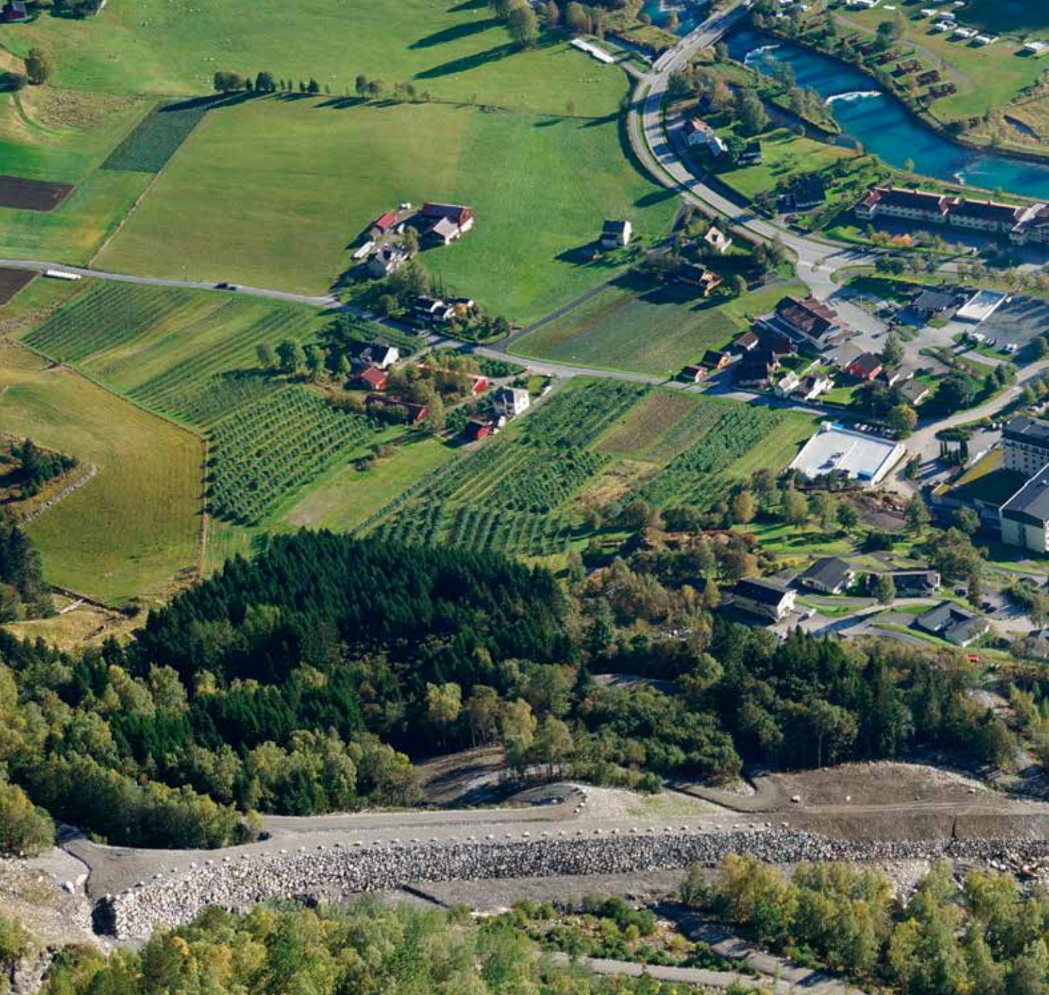
Snøskredsikring i Gjølmunna i Loen i Sogn og Fjordane. Skredvallen tryggjer lokal busetnad og det kjende Aleksandra Hotell. Foto: Krister Kristensen, NGL.
