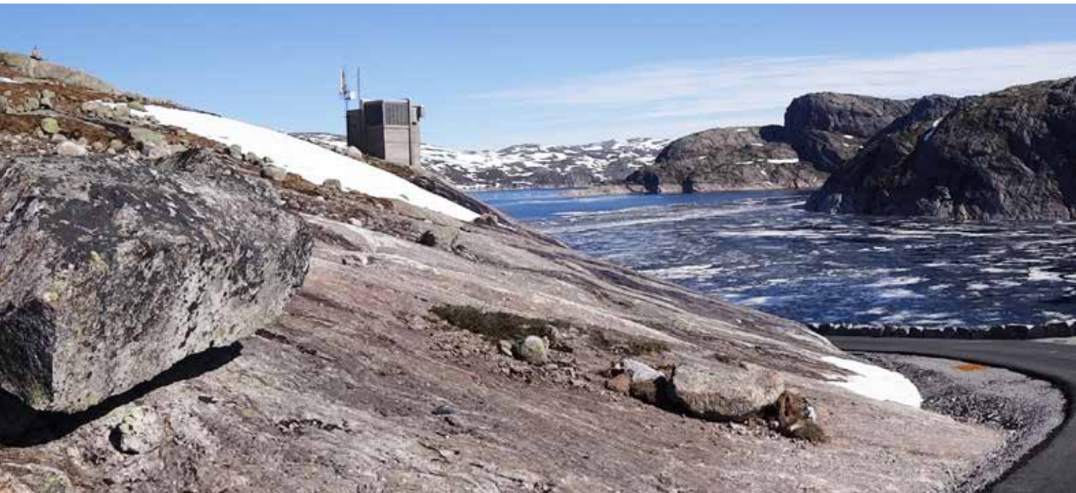
Svartevannsdammen i Sira Kvina. Foto: Torodd Jensen / NVE.
