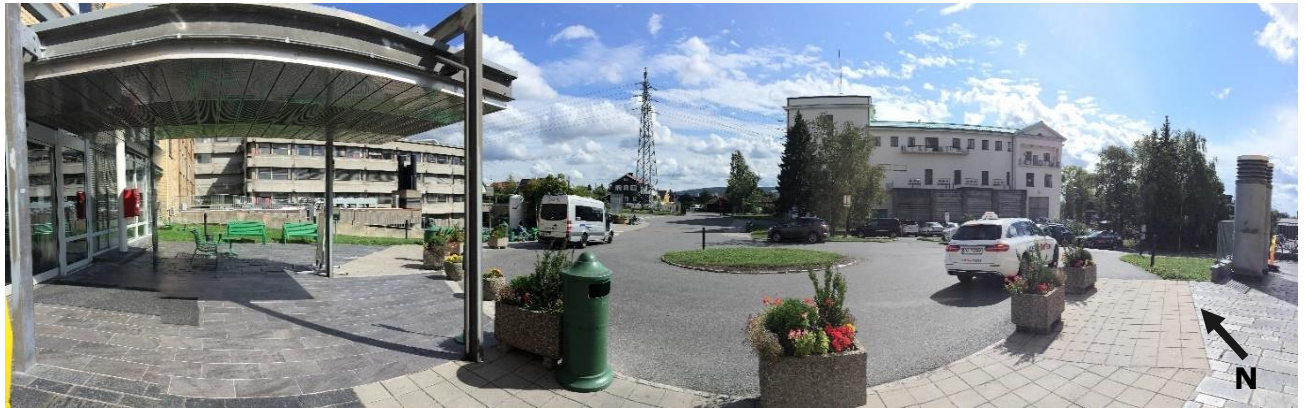
Figur 13. Eksisterende hovedinngang sett fra sør
