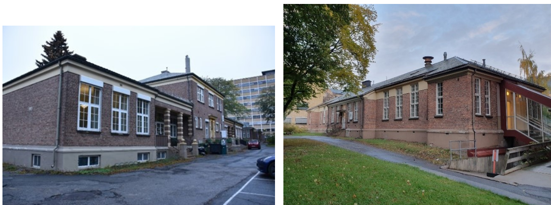
Figur 17 Til ventre Bygning 21, høyblokka bygning 6 i bakgrunnen. Til høyre Bygning 9, som ligger vis a vis bygning 8. Foto Kulturminneconsult 2019
