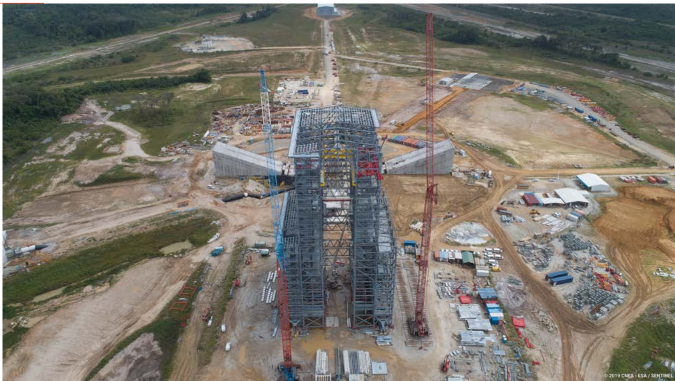
Her bygges oppskytingsrampen for Ariane 6 ved Kourou. Foto: ESA.
