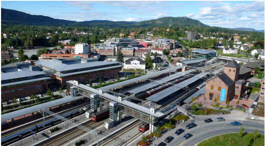
Over til venstre: Asker sentrum. Foto: Asker kommune Under: Asker stasjon. Foto: Asker kommune
