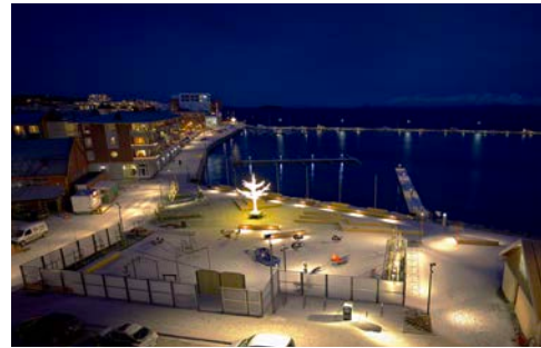
Havnepromenaden med bølgedemper. Foto: Øivind Arvola
