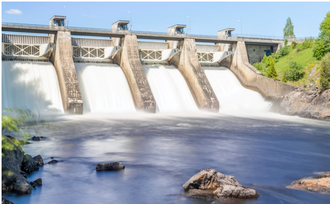
Illustrasjonsbilde av Hunderfossen kraftverk
