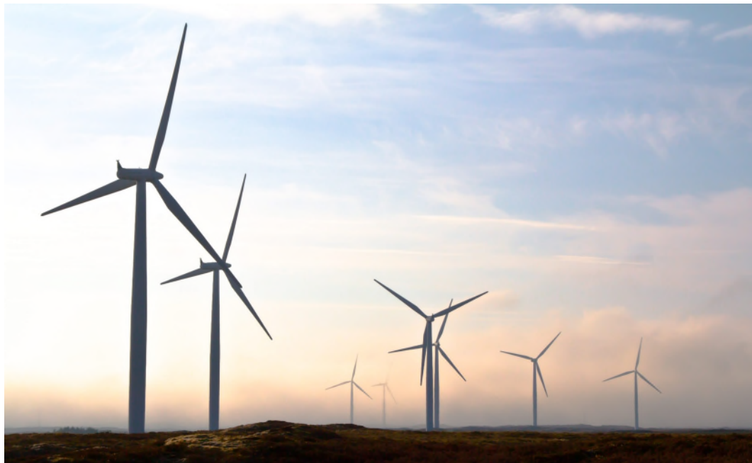
Illustrasjonsbilde av Smøla vindkraftverk
